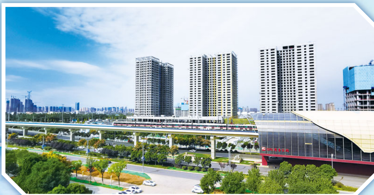
Xi'an Metro (Guoji Gangwuqu Station) 西安地鐵站(國際港務區站)
