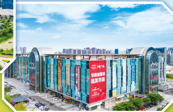
Trade Centre Plaza No. 3 in CSC Nanning 南寧華南城的 3號交易廣場
